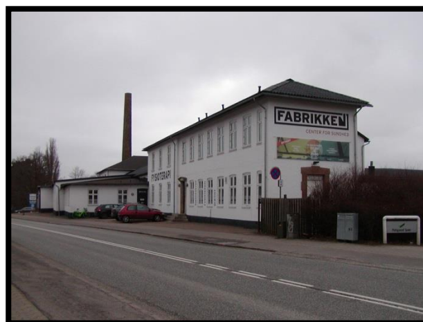
Den første Slagelse Station, der blev margarinefabrik og i dag fungerer som træningscenter med fysioterapi 2017
