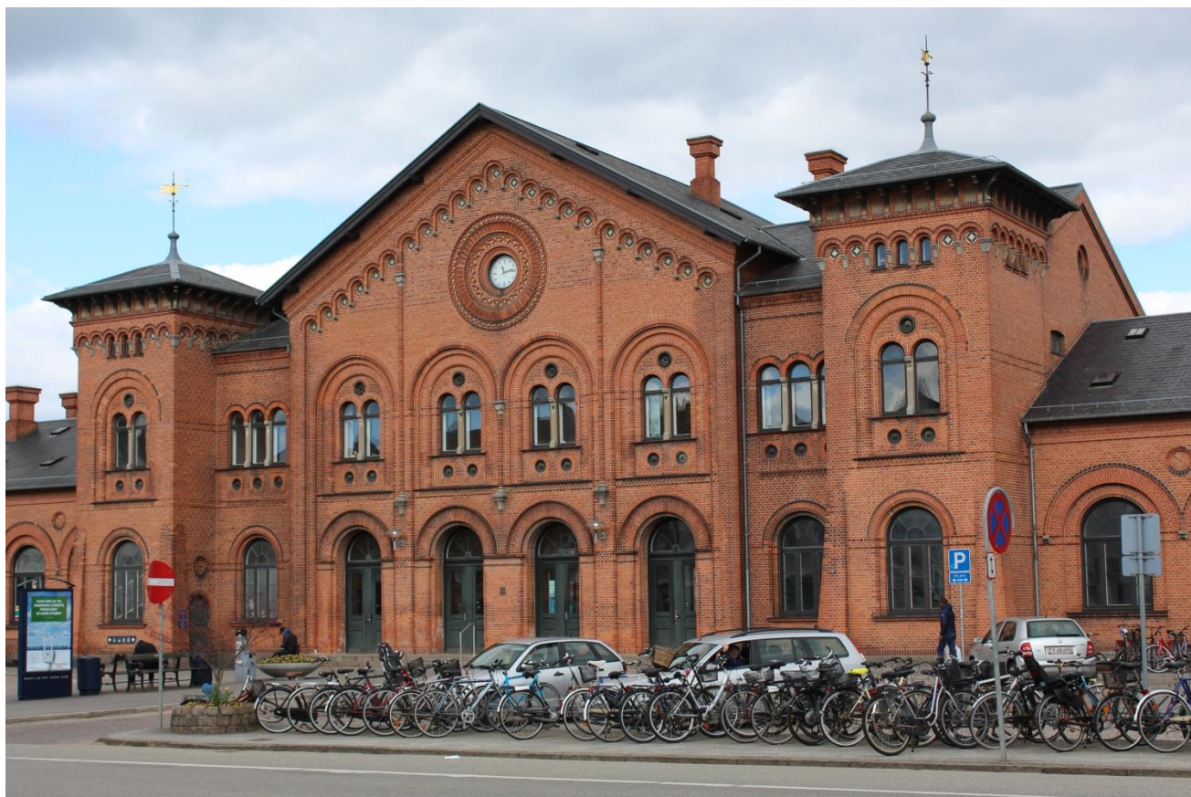
Slagelse Station Søndre Stationsvej 2017
